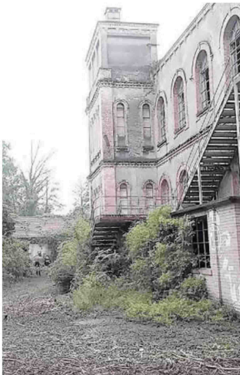
EX COTONIFICIO L'ex Makò di Cordenons può essere trasformato in un'area residenziale oppure direzionale
